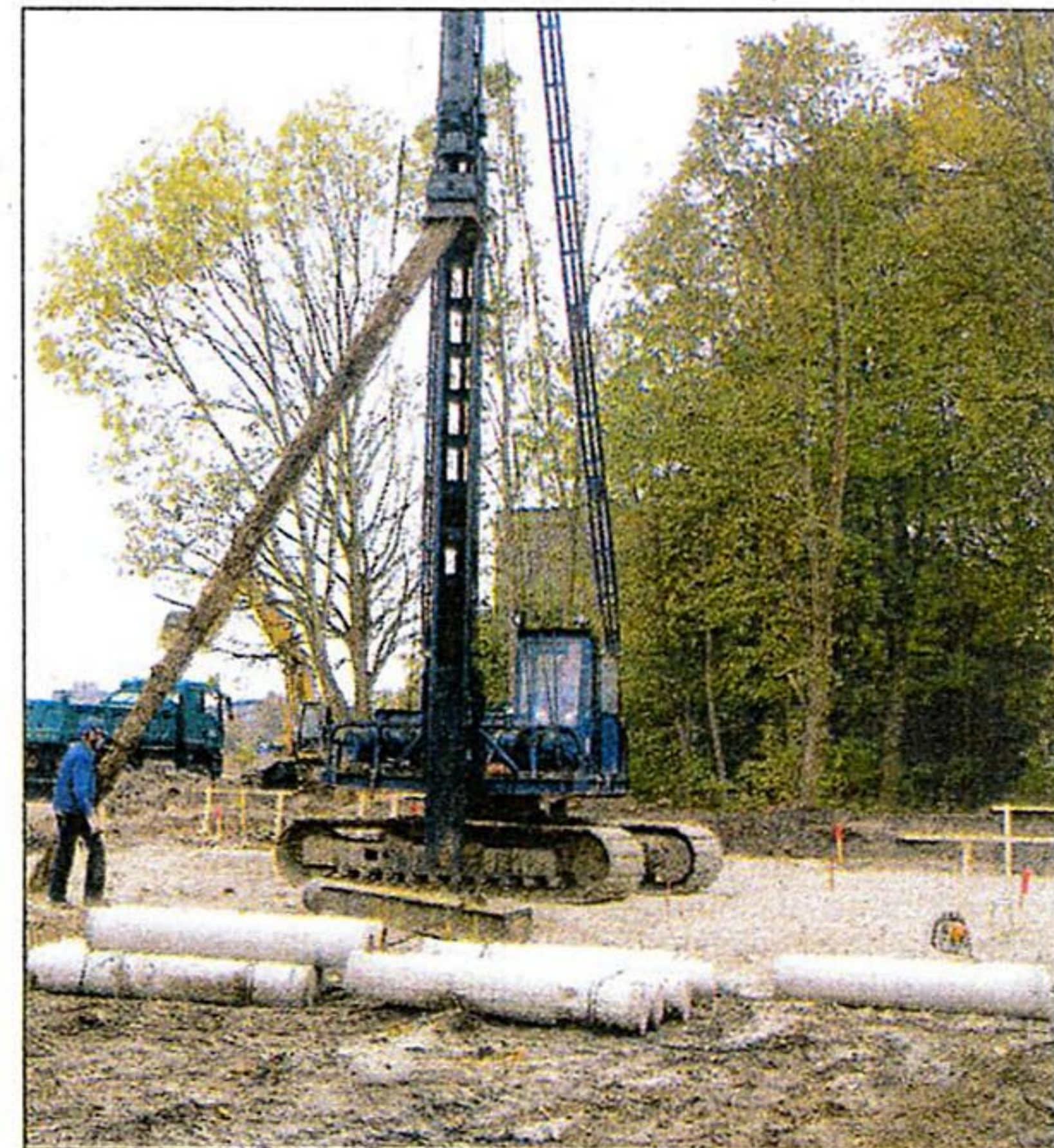
Rammen für das Eigenheim am Eisenbahndock: Gestern begann der zweite Bauherr mit der Gründung für sein Eigenheim im Baugebiet „Neuer Delft“.
